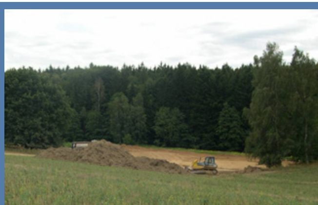
Zavážení a plošné zarovnávání povrchu.
