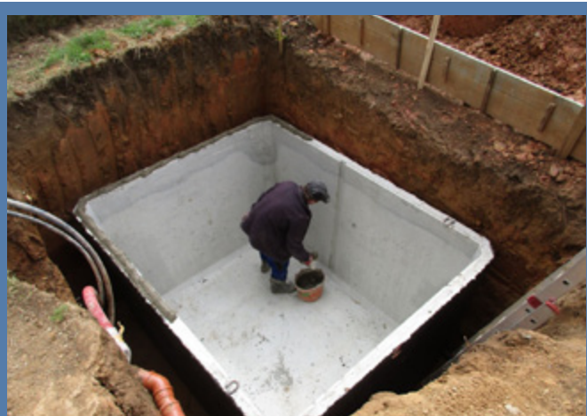
Instalace nádrže na dešťovou vodu.
